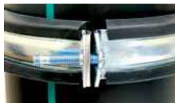
Befestigungsebene, untere feste Schelle
