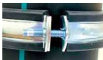
Befestigungsebene, untere feste Schelle
